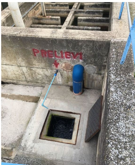
Figura 12: Foto del pozzetto terminale della linea biologica
